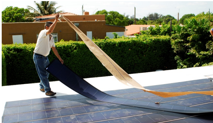
Transluente (doorschijnende) PV op het glasdak van een aanbouwserra; zonwering en zonnestroomopwekking in één. Thin film PV is ook 'aan de rol' leverbaar, bijvoorbeeld voor toepassing op platte daken. © ejn en internet
