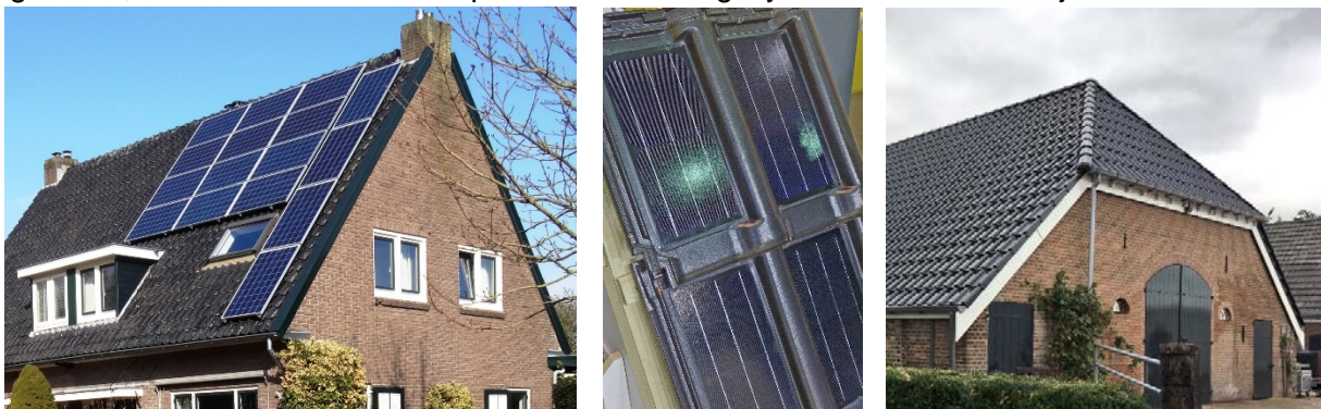
Polykristallijne PV op het dak van een jaren dertig huis. Het huis is daarmee vermoedelijk elektrisch zelfvoorzienend. Maar het ziet er rommelig uit; dergelijke beeldschade is bij monumenten ongewenst. Midden en rechts: voorbeeld en toepassing van PV-dakpannen. De panvorm is modern. © ejn en Nelskamp.
