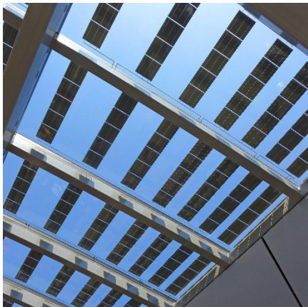
Transluente (doorschijnende) PV op het glasdak van een aanbouwserra; zonwering en zonnestroomopwekking in één. Thin film PV is ook 'aan de rol' leverbaar, bijvoorbeeld voor toepassing op platte daken. © ejn en internet
